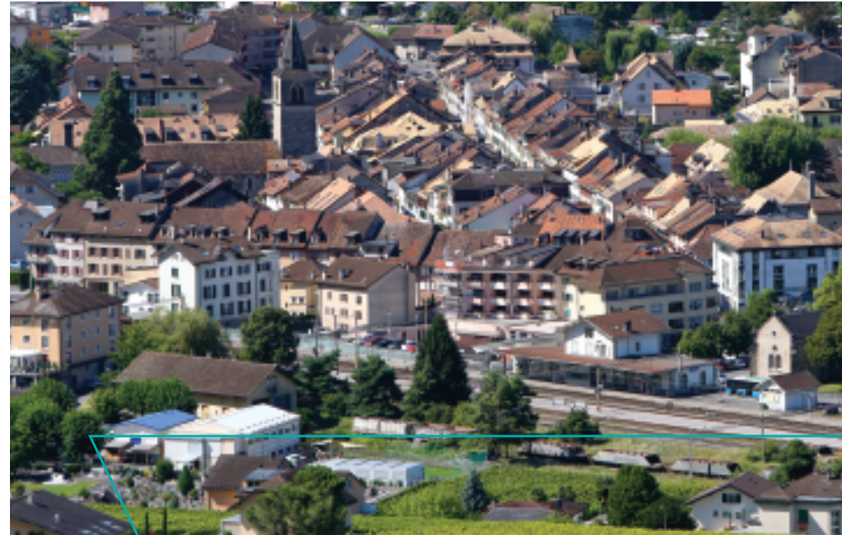
Le schéma directeur « Portes du Bourg » a pour objectif de repenser les contours du périmètre de la gare.
